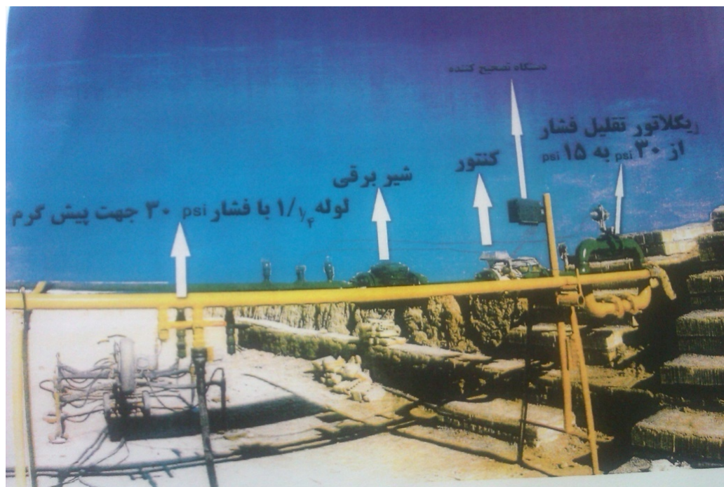
شکل ۴-۱۱: موقعیت قرارگیری ریگلاتور کاهش‌دهنده فشار
